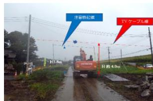
バックホウのアームを上げたまま走行したことにより架空線を損傷した事故の写真
